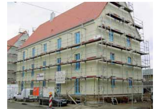
Der Vollwärmeschutz ist schon fertig
